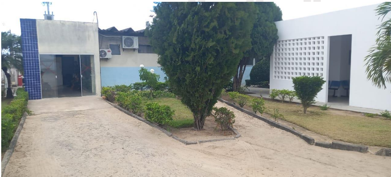
Foto 05 Acesso que deverá ser interligado a ampliação a ser proposta
